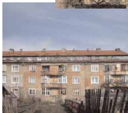
Insterburg Fassade Juri-Gagarin-Straße (2)
