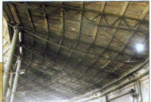
Bild 10, Fischbauchträger im unteren Dachbereich (5)
