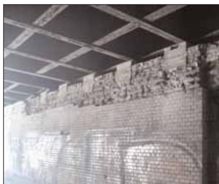
Betonpolster unter den Brückenträgern
