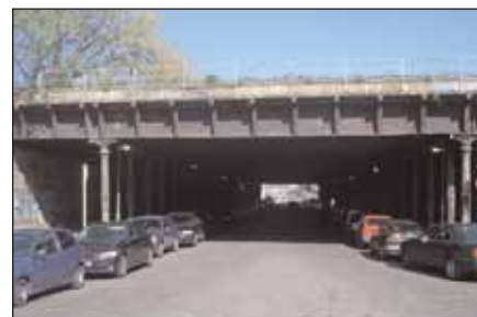
Fahrbahnbereich, Blick Richtung Osten
