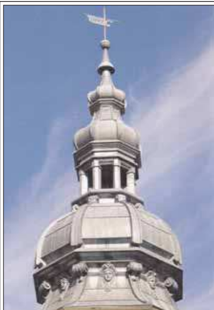
Bild 10 Villa Hirschgarten, Wißlerstr. (6, S. 79)
