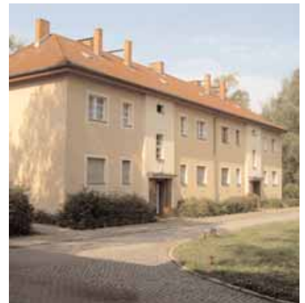
Berlin Fassade Clayallee
