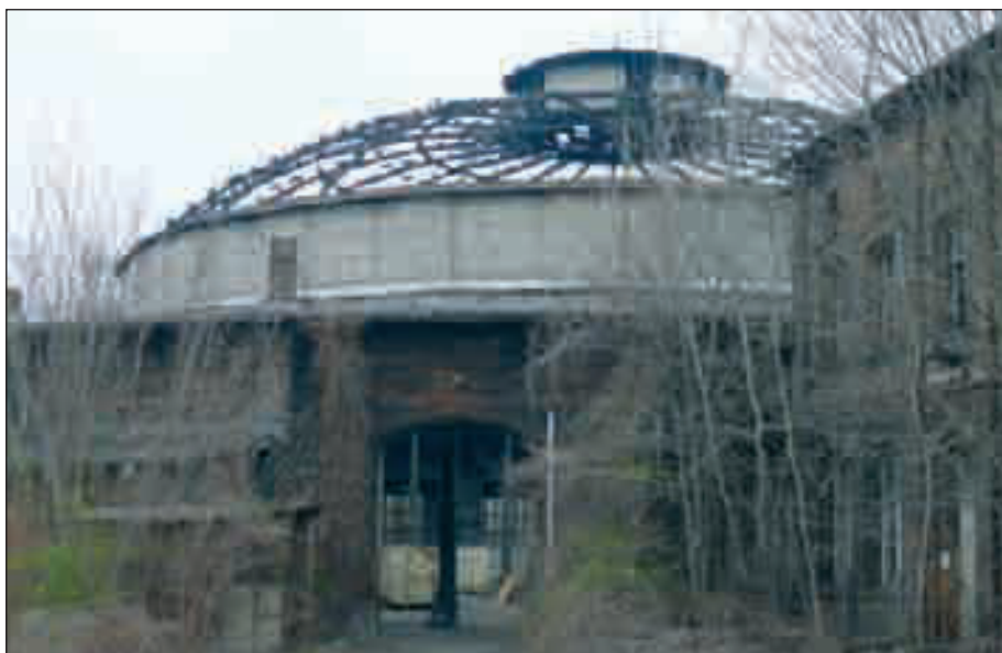
Bild 5, Rundlokschuppen in Berlin-Rummelsburg im April 2011 (6)
